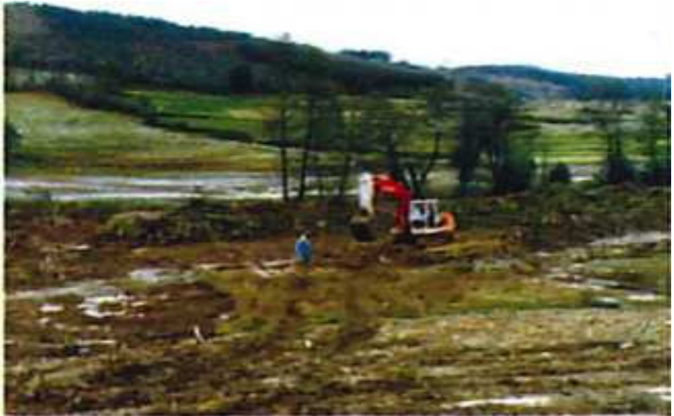
Figura 9. Retirada de tierra superficial, 1993.
